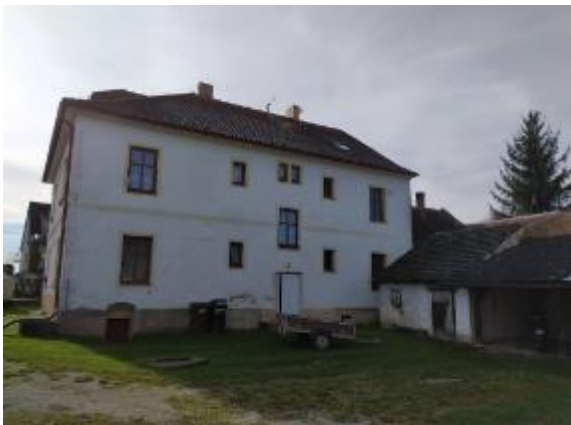
Obrázek č. 26: Obecní bytovka č.p. 80; zdroj: vlastní, autor
